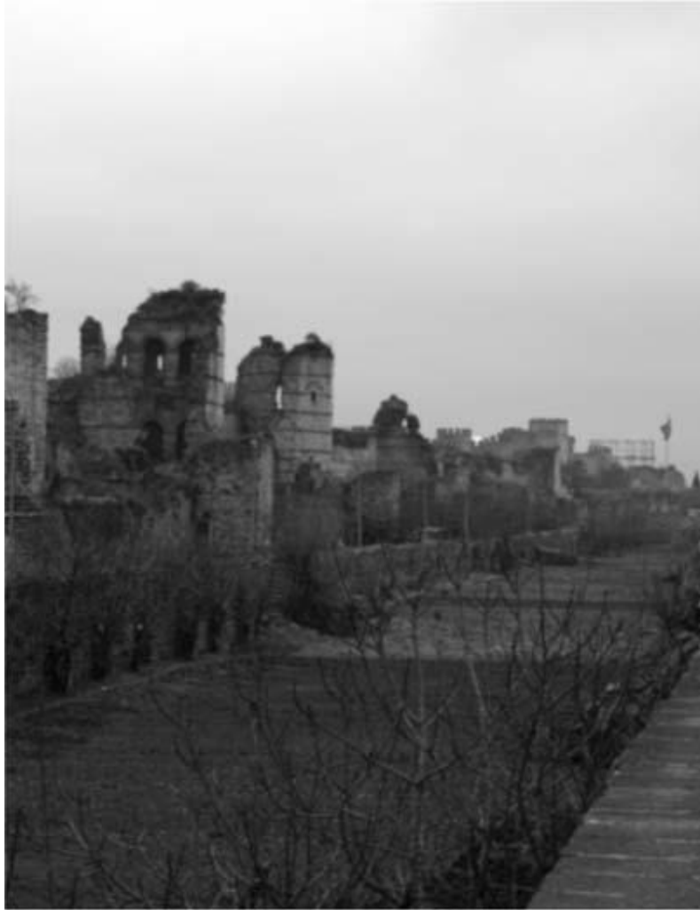
Foso de las murallas de Teodosio II. Los entramados defensivos de las ciudades del Medioevo estaban formados principalmente por una muralla y un foso. Cuando un ejército sitiaba una urbe, para poder llevar a cabo el asalto final a la muralla era preciso cegar el foso. En esto fue en lo que se concentraron precisamente buena parte de los esfuerzos otomanos antes de lanzarse sobre la muralla principal de Constantinopla en 1453.
